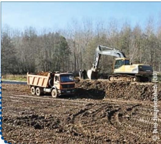
Arbeiten zur Verbesserung der seitlichen Durchgängigkeit und Flussdynamik: Beseitigung von Erdwällen
