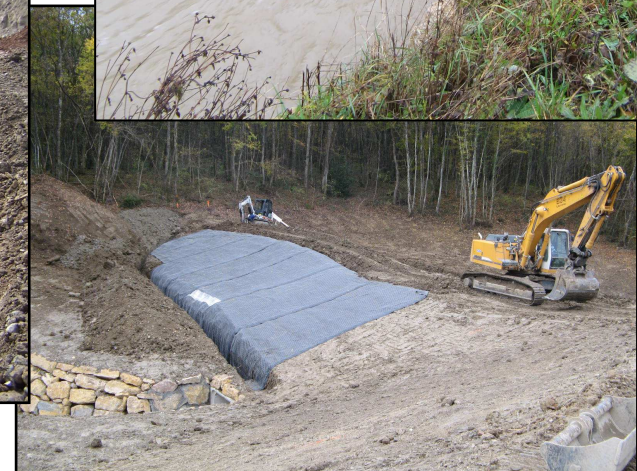
Membrane bentonitique + terre végétale et enherbement
